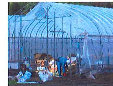
写真48 ハウス骨材と被覆資材の補修作業の状況
