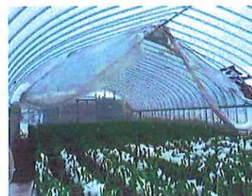
写真47 被覆資材が破損し、作物が雪を被った状況
