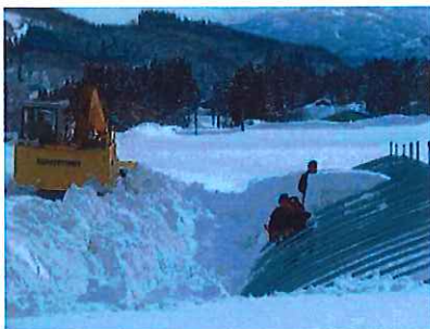
写真 24 グループ作業による除雪の状況
