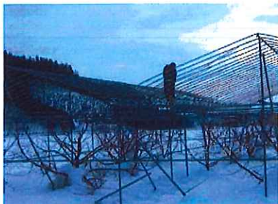
写真 26 おうとう雨よけ施設の雪下ろし作業の状況
