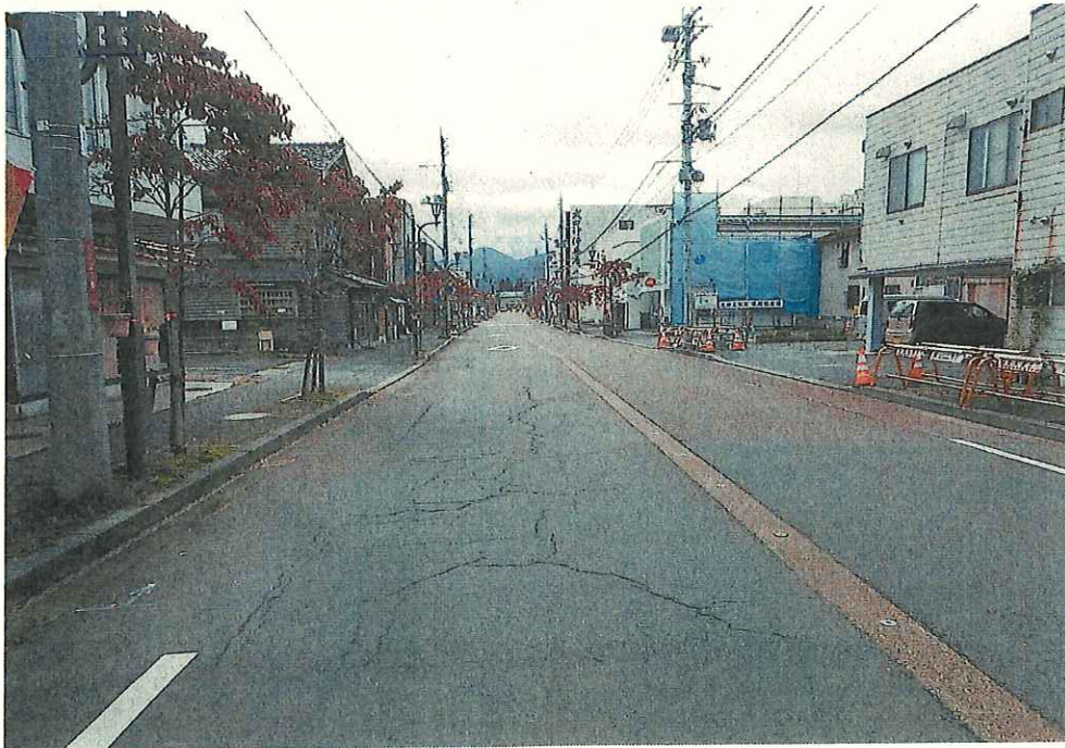
解除区間北側から南側を見た状況
