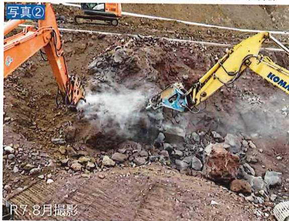
▼川袋地区における掘削状況(硬い岩盤が出現)
