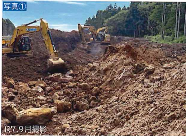
▼(仮)吹浦IC周辺における掘削状況(転石が出現)
